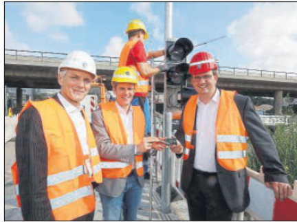
An den Doppelkreuzungen im Kaiserlei wird von der EVO modernste Ampeltechnik installiert: Günther Weiß, Felix Schwenke und Christoph Meier überzeugten sich davon. • Fotos: EVO
