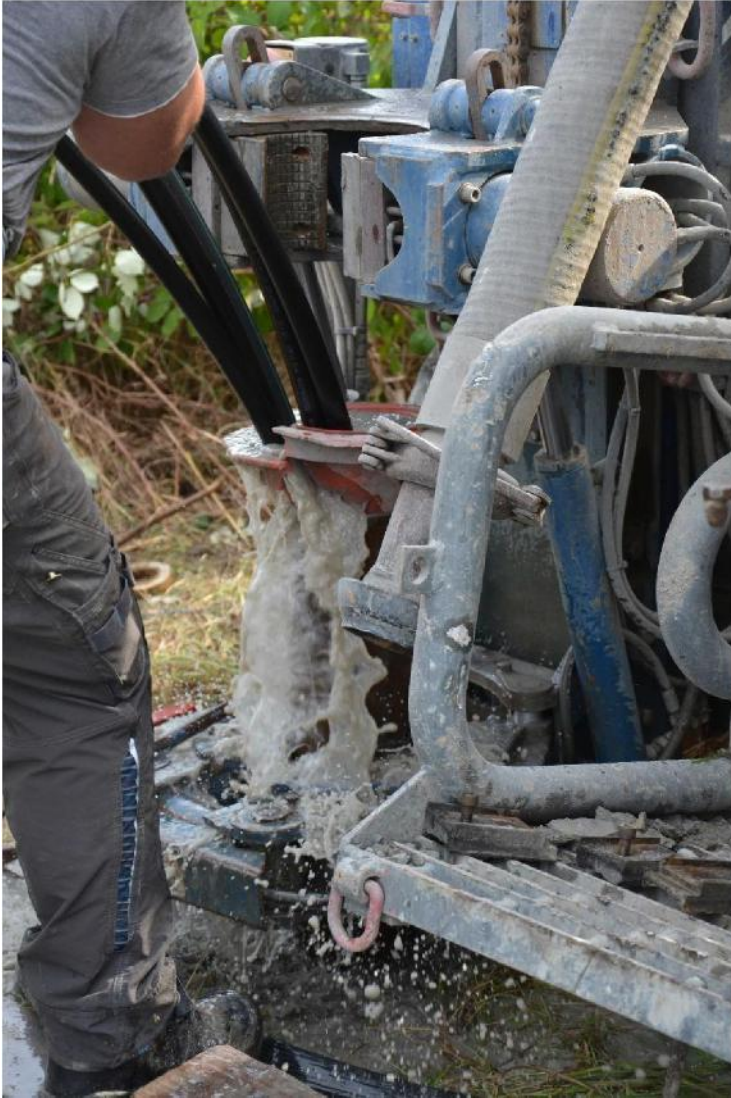
Einbringen der Sonde ins Bohrloch Chargenmischer für Verfüllbaustoff Stockstadt am Rhein, 14.09.2021
