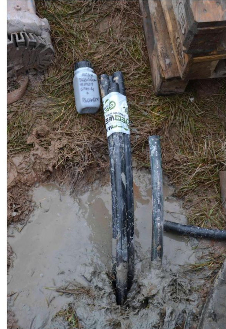
Verfülltes Bohrloch mit EWS
