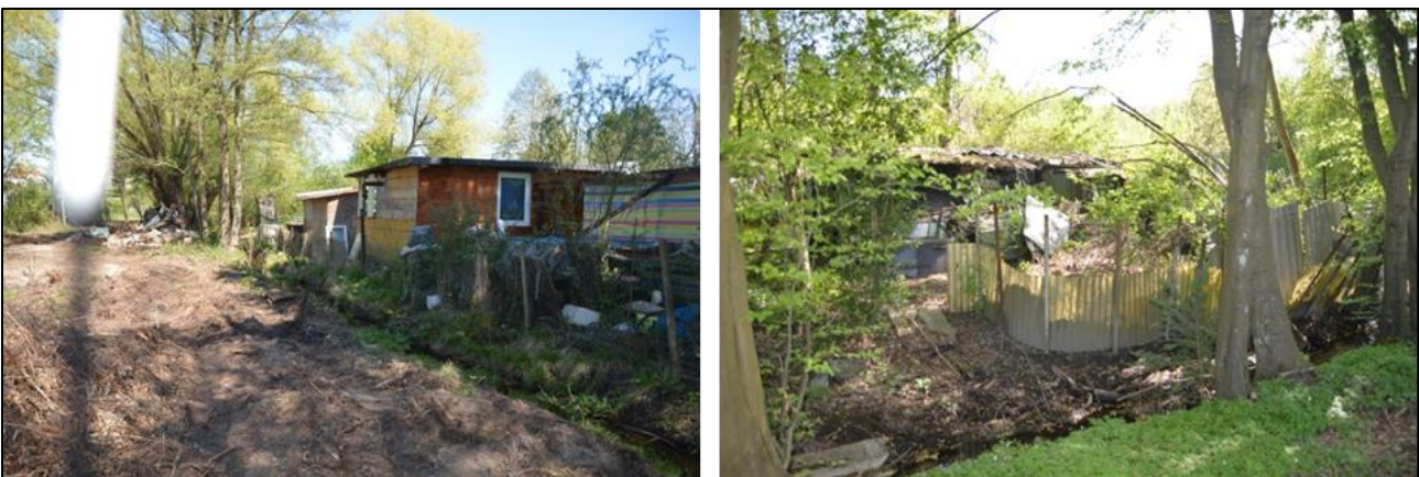
Abbildung 49: Unzulässige Bauten am Röhrgaben; nicht zugänglicher Abschnitt innerhalb der Kleingartensiedlung. Quelle: Stadt Offenbach, 2017.
