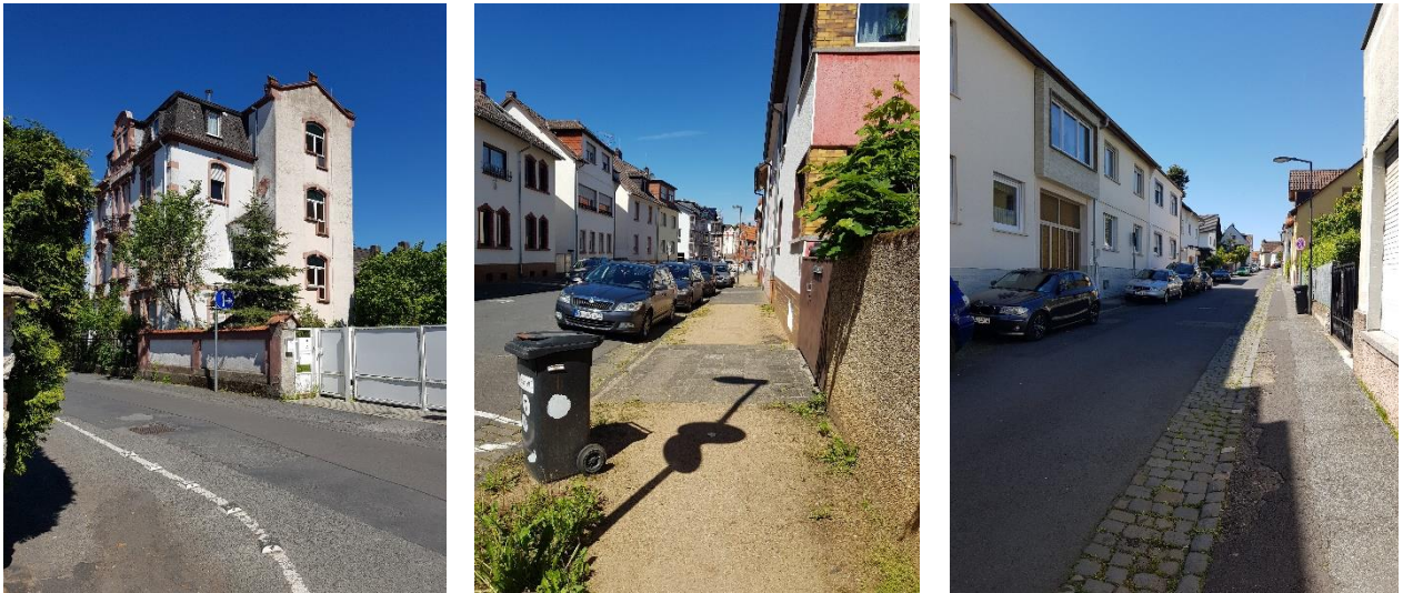
Abbildung 212: Aufgemalter Gehweg, Fußweg mit wassergebundener Decke und Unkraut, maroder, abgesenkter und schmaler Fußweg. Quelle: Stadt Offenbach, 2020.
