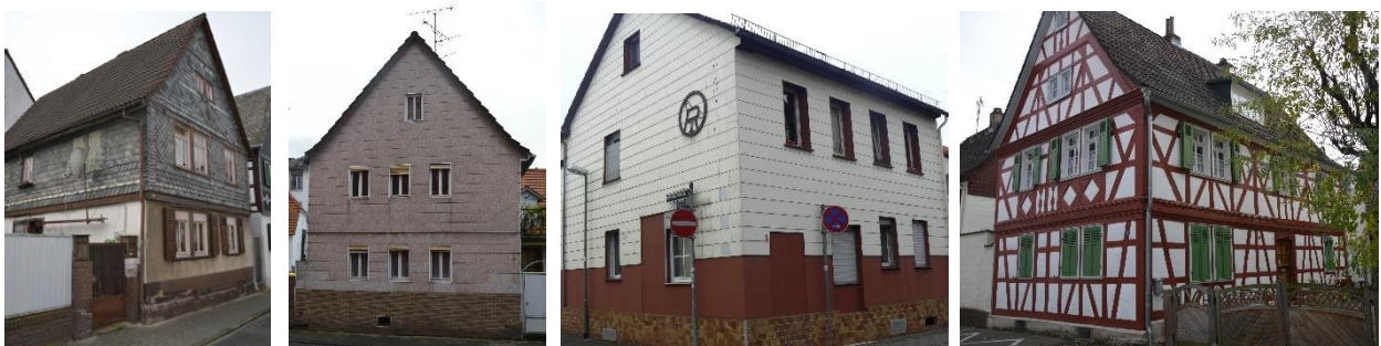
Abbildung 114: Gebäude mit Sanierungsbedarf, zwei Gebäude mit leichten Mängeln und erhaltenswerte historische Fassade im mittelalterlichen Ortskern. Quelle: Stadt Offenbach, 2017.
