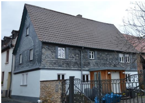
Abbildung 228: Verortung und Bild eines historischen Gebäudes. Quelle: Stadt Offenbach, 2017.
