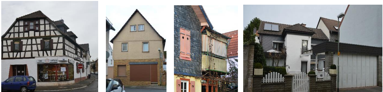
Abbildung 117: Unangemessene Werbung, stilistisch unstimme Fassade und zwei Bilder unangepasster An- / Vorbauten im mittelalterlichen Ortskern. Quelle: Stadt Offenbach, 2017.
