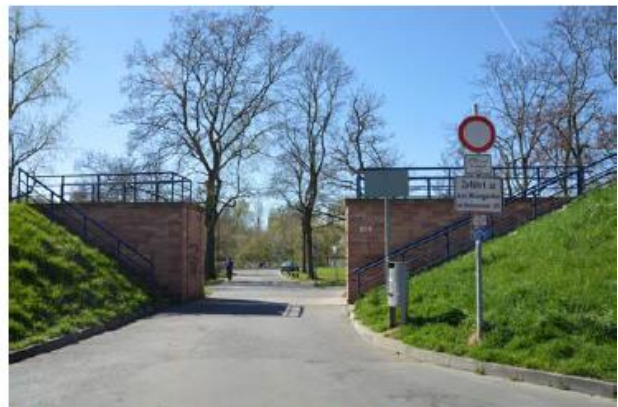
Maindamm Durchgang (Fotos: Stadt Offenbach)
